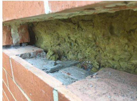
Abbildung 10: Rückhaltewinkel Sondage Nord-Ost
