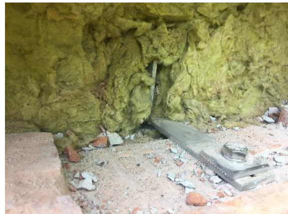
Abbildung 12: Rückhaltewinkel Sondage Nord-West
