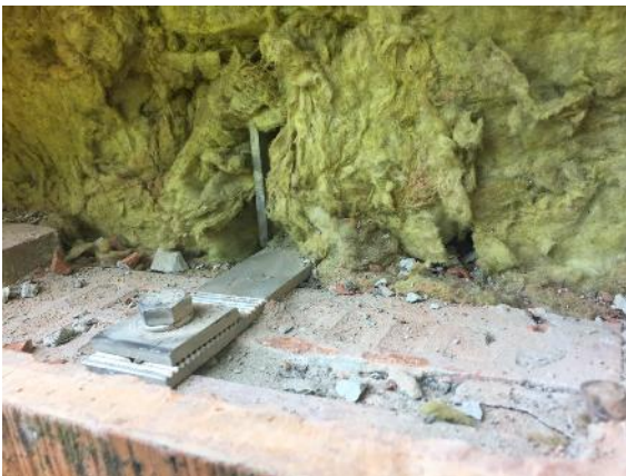
Abbildung 11: Rückhaltewinkel Sondage Nord-West
