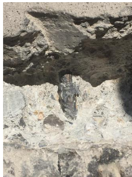
Abbildung 22: Armierung Sondierfenster 2
